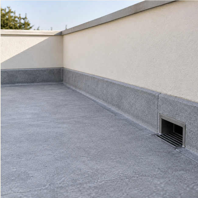
Toiture : relevés & évacuation
