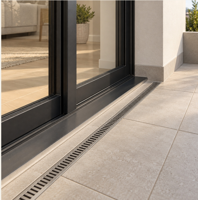
Balcon : seuil & écoulement
