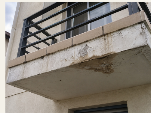
Balcons et terrasses
