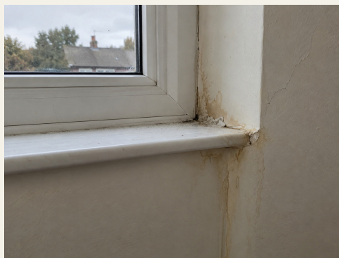
Façades, fissures et joints
